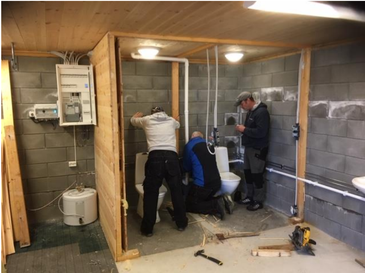
Ombygging av toalett på Kjeltringholmen til HC toalett.
